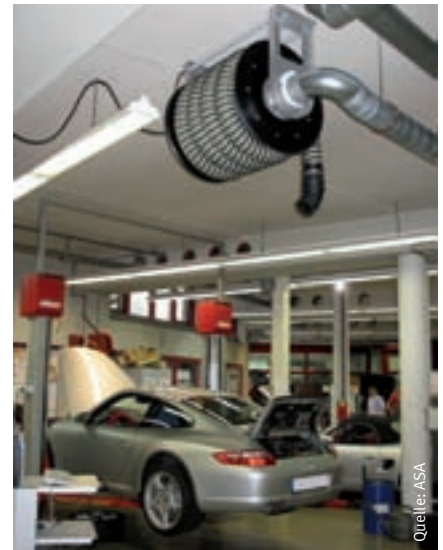
Abgasschlauch - Aufroller mit Hochtemperaturschlauch
