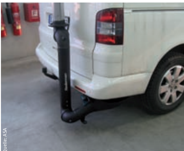
Bild links: Berührungslose Absaugeinrichtung für alle Fahrzeugtypen
